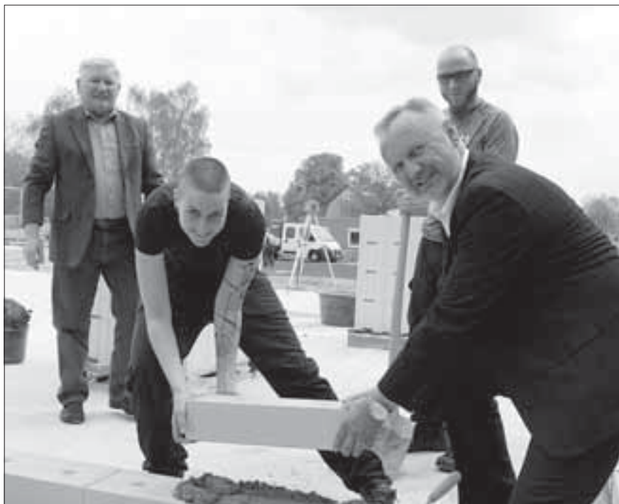
Bei den Bauarbeiten am Jugendhaus (v. l. n. r.): Ortsteilbürgermeister Manfred Claus, Sozialarbeiterin Katja Hönig, Bürgermeister Ortwin Baier und Sozialarbeiter Jens Bellmann.
