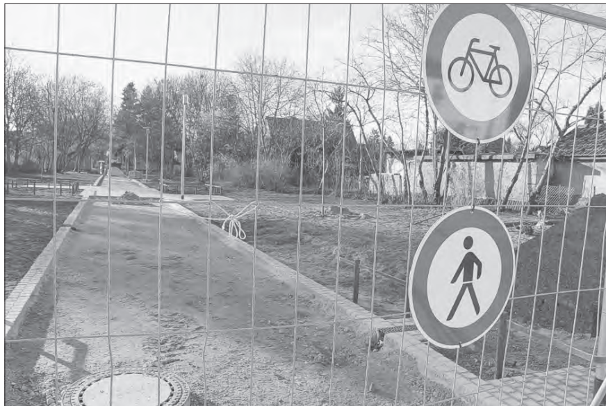
Der erste Bauabschnitt der Märkischen Promenade: Derzeit noch eine Baustelle – die offizielle Eröffnung findet am 17. April statt
