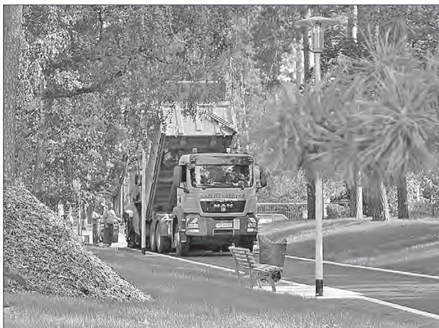
Die letzten Wegebauarbeiten wurden Ende September abgeschlossen
