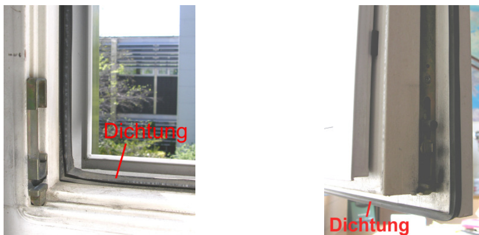
Abbildung 4: Dichtungen an Fensterrahmen und Fensterflügel
