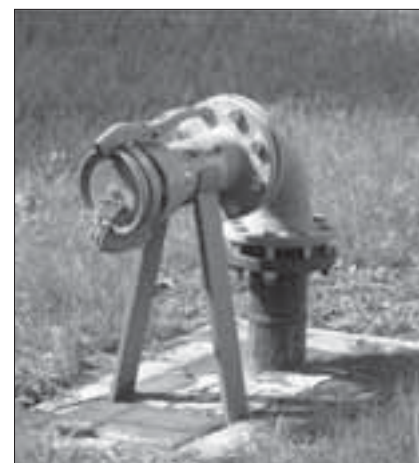
Foto KMS – Beispiel Perrot-Kupplung
